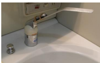
【写真④】水洗レバーの延長
