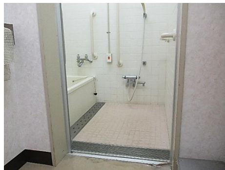
(写真1)バリアフリーの浴室出入口
