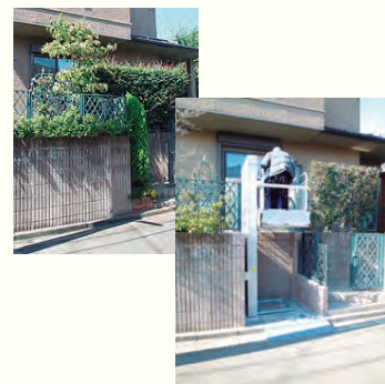
【住宅・肢体不自由・段差解消機】
