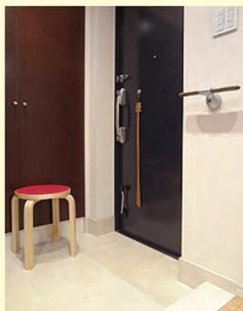
手すりは、玄関土間からの高さ 99 cm、室内床からの高さ 92 cm。高めの手すりは腕全体を乗せられ、短めの手すりは先端を両手で持てます。椅子に座って靴を脱ぎ履きます。
