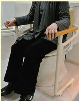
トイレの手すりは、壁にL型手すりを取り付ける整備が一般的ですが、手すりを握ることが難しい場合には、腕全体で力を加えられる肘掛け式の手すりを検討すると良いでしょう。
