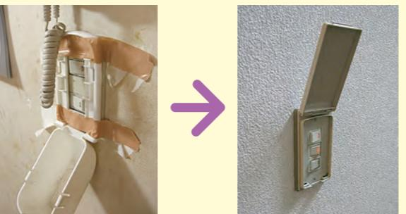
カバー付きのスイッチプレートに交換するだけで、何度も押す行動を防げる場合もあります。
